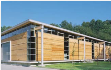
Завод по производству фитингов из нержавеющей и углеродистой стали NiroSan®-Press, г. Шмидефельд, Германия
