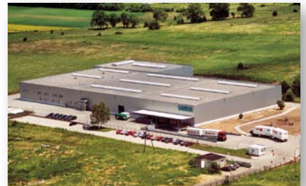
Производственно-логистический центр SANHA, Легница, Польша
